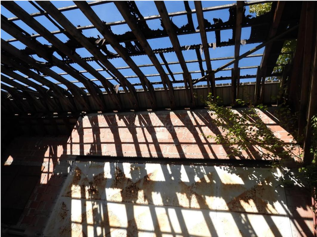
Bild 07: Das Dach im Anbau ist in diesem Bereich fast vollständig abgedeckt
